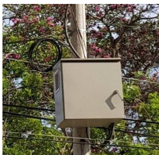
Ilustración 22 Gabinete de networking
